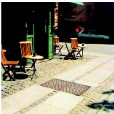
Eksempel fra København på teknik placeret under terræn.
