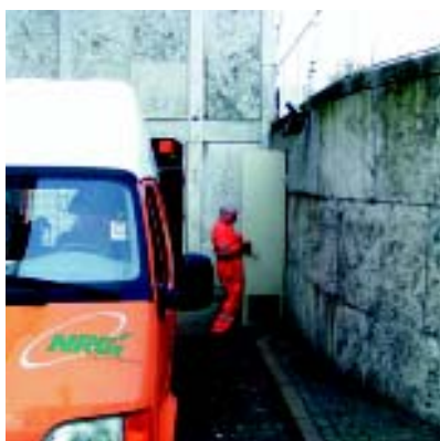
Eksempel på teknikrum.
