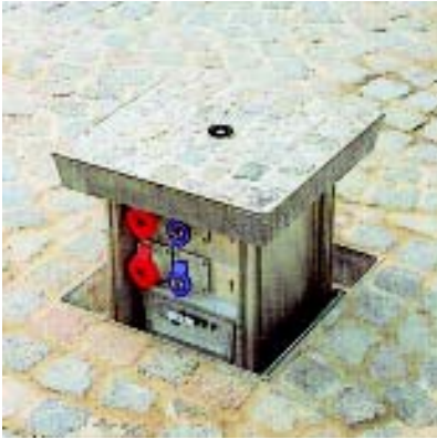
Eksempel på et sænkbart elskab fra Moser System Elektrik (Foto fra brochure fra DAN-INTRA GRUPPEN).
