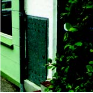
Indbyggede kabelskabe vil kunne se ud som f.eks. de „skabe“, man ser til affaldsspande (ren overflade uden plakater og graffiti).
