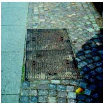
Teknik under terræn, eksempel fra Århus.
