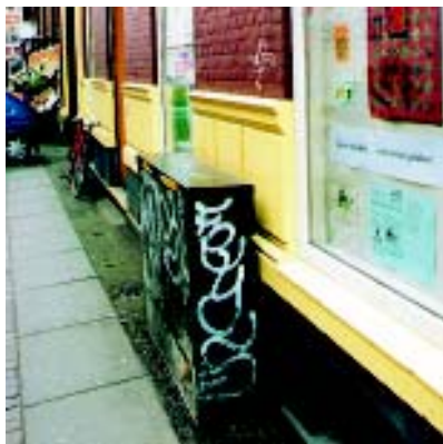
Uheldig placering uden hensyn til bygningens udsmykning.
